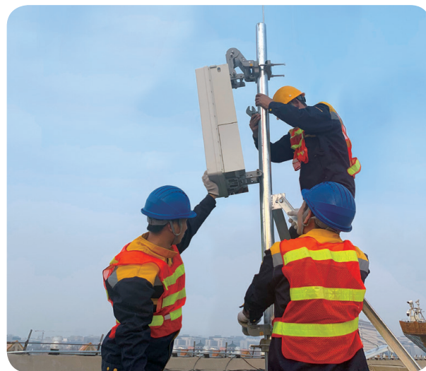
Установка 5G-терминалов Huawei 64T64R AAU — универсальных узлов связи 5G Huawei — позволяет быстро развернуть крупную 5G-сеть в любой точке мира
